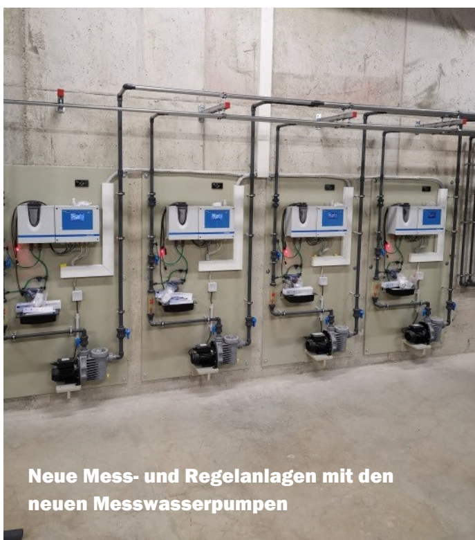
Neue Treibwasserpumpen mit Chlorregelanlagen
