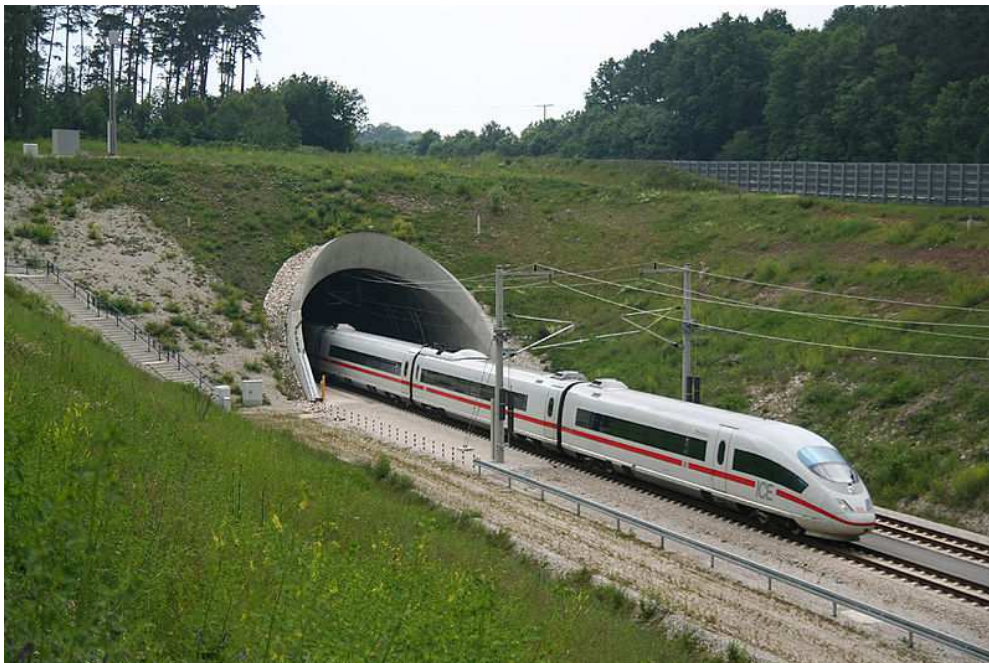
Südportal des Göggelsbuch-Tunnels, Neubaustrecke Nürnberg–Ingolstadt, mit ICE 3 Foto: Sebastian Terfloth
