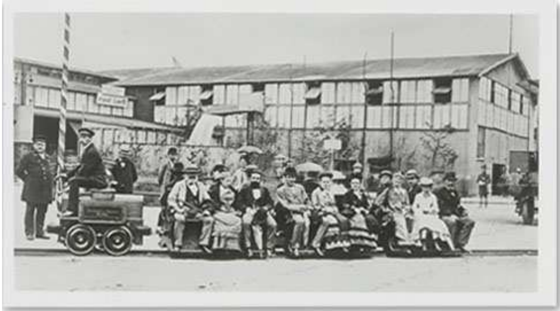
Elektrolokomotive von Werner von Siemens auf der Gewerbeausstellung in Berlin 1879
